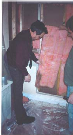
Photo #8 Même endroit que la photo #7, mais avant de rebretter du mur le carton-fibre et la laine acoustique.
