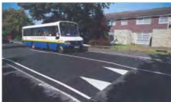
Figure 14 Plateau ralentisseur : une mesure conçue pour les voies plus rapides et les véhicules lourds
