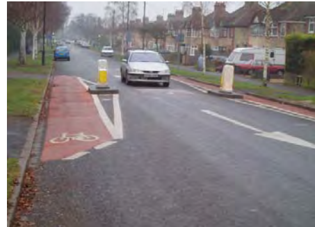
Figure 24 Deux rétrécissements de la chaussée aux configurations différentes
