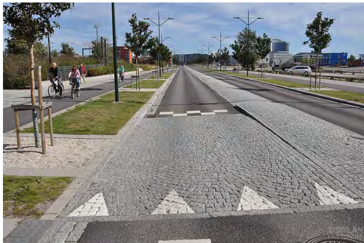
Photo 3 Exemple d'une intersection surélevée, Malmö, Suède
