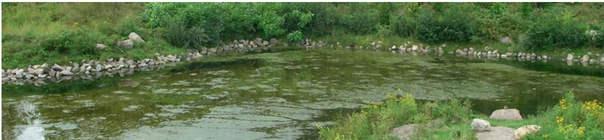
Figure 12 The Parc de la Montagne-des-Roches retention pond
